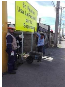
9.1.14 Instalación de señaléticas en la Comuna
