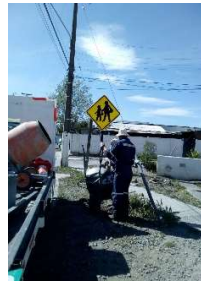
9.1.15 Limpieza de canales y desagües en la Comuna
